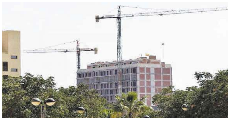
Construcción de viviendas en la ciudad de Murcia.
